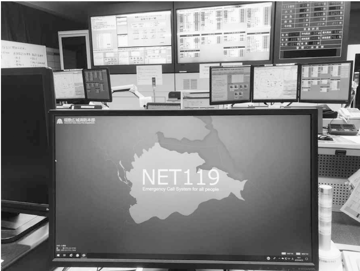
●NET119 緊急通報システム
