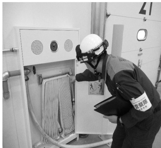
(消防用設備等確認の様子)
